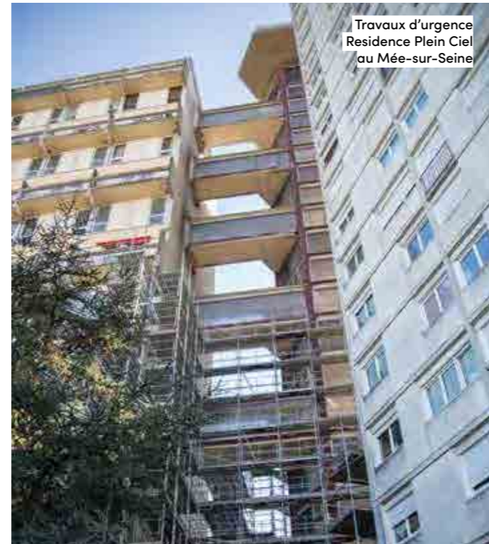
La réhabilitation du 10 rue Carnot à Melun
